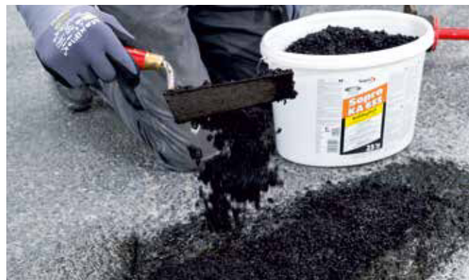
2 Sopro KaltAsphalt felhordása
