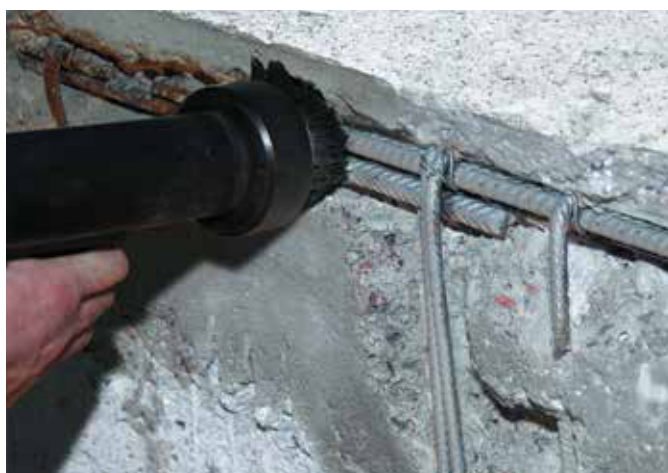
1. Aljzatelőkészítés homokszórással
