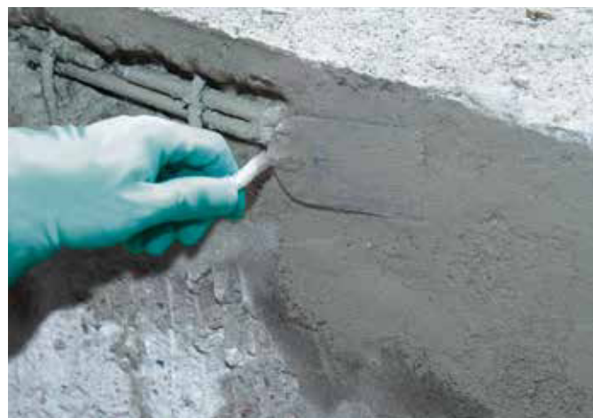
4. Javítóhabarcs bedolgozása Repadur 50-nel
