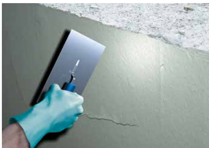
5. Felület lezárása Repadur 5-tel
