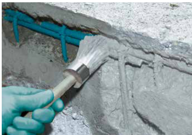
3. Tapadóhíd felvitele Repadur MH-val
