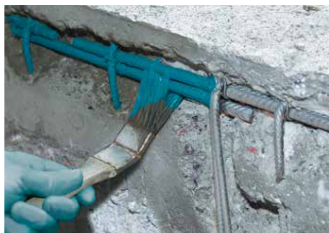
2. Korrózióvédelem Repadur KS-sel
