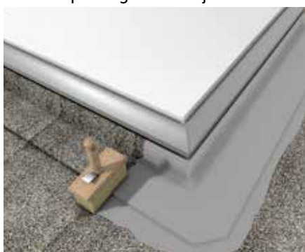
Tetőn átfedések szigetelése és lezárása
