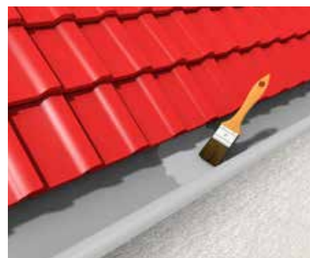
Ereszcsatornák szigetelése és javítása
