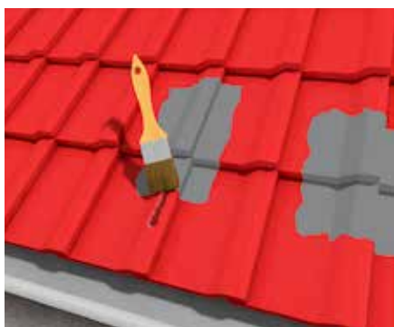
Tetőcserepek szigetelése és javítása
