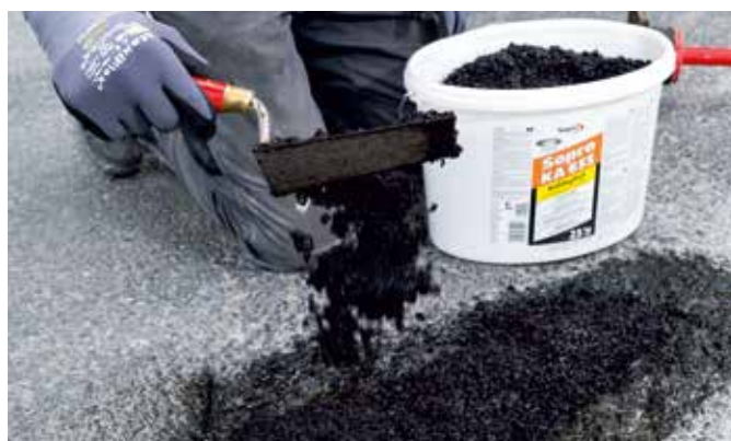
2 Sopro KaltAsphalt felhordása
