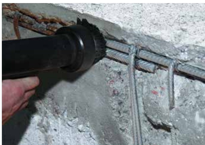
1 Aljzatelőkészítés homokszórással
